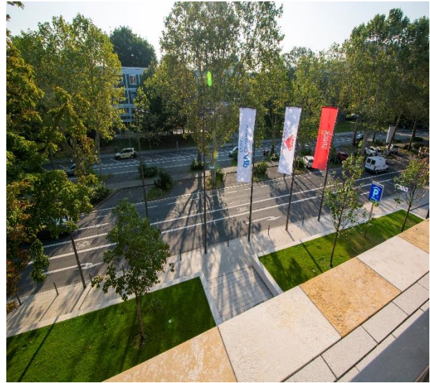
Masten Halle Süd
