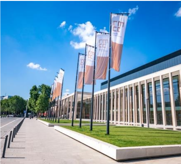
Masten Halle Nord
